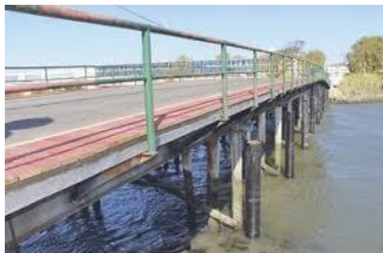
A ponte de madeira da Vista Alegre actual e durante as obras de substituição de estacaria “Ponte de madeira com estacaria metálica, após Outubro de 2015”
